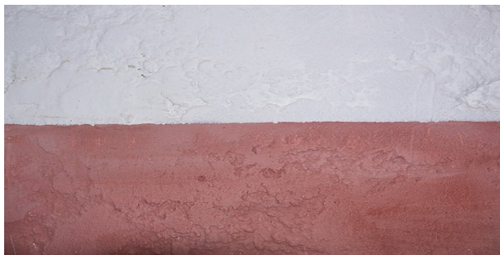
Badigeons de chaux colorés aux oxydes de fer appliqués directement sur de vieux enduits ciment
