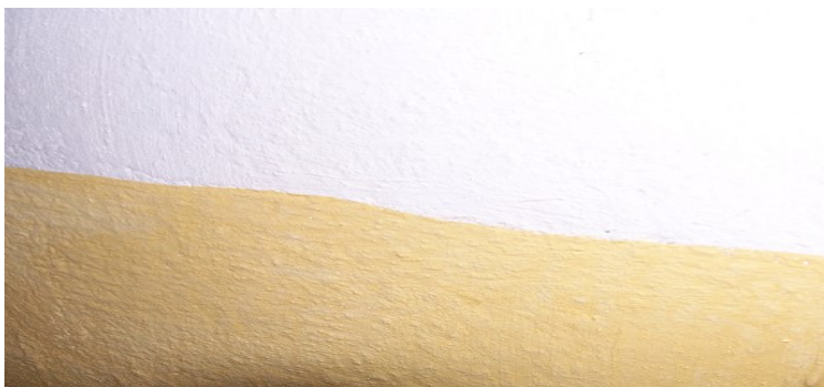
Badigeons de chaux colorés aux oxydes de fer appliqués directement sur de vieux enduits ciment
